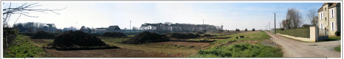
Premiers terrassements en vue de la réalisation d'un lotissement de 7 pavillons, non loin de la Mairie
